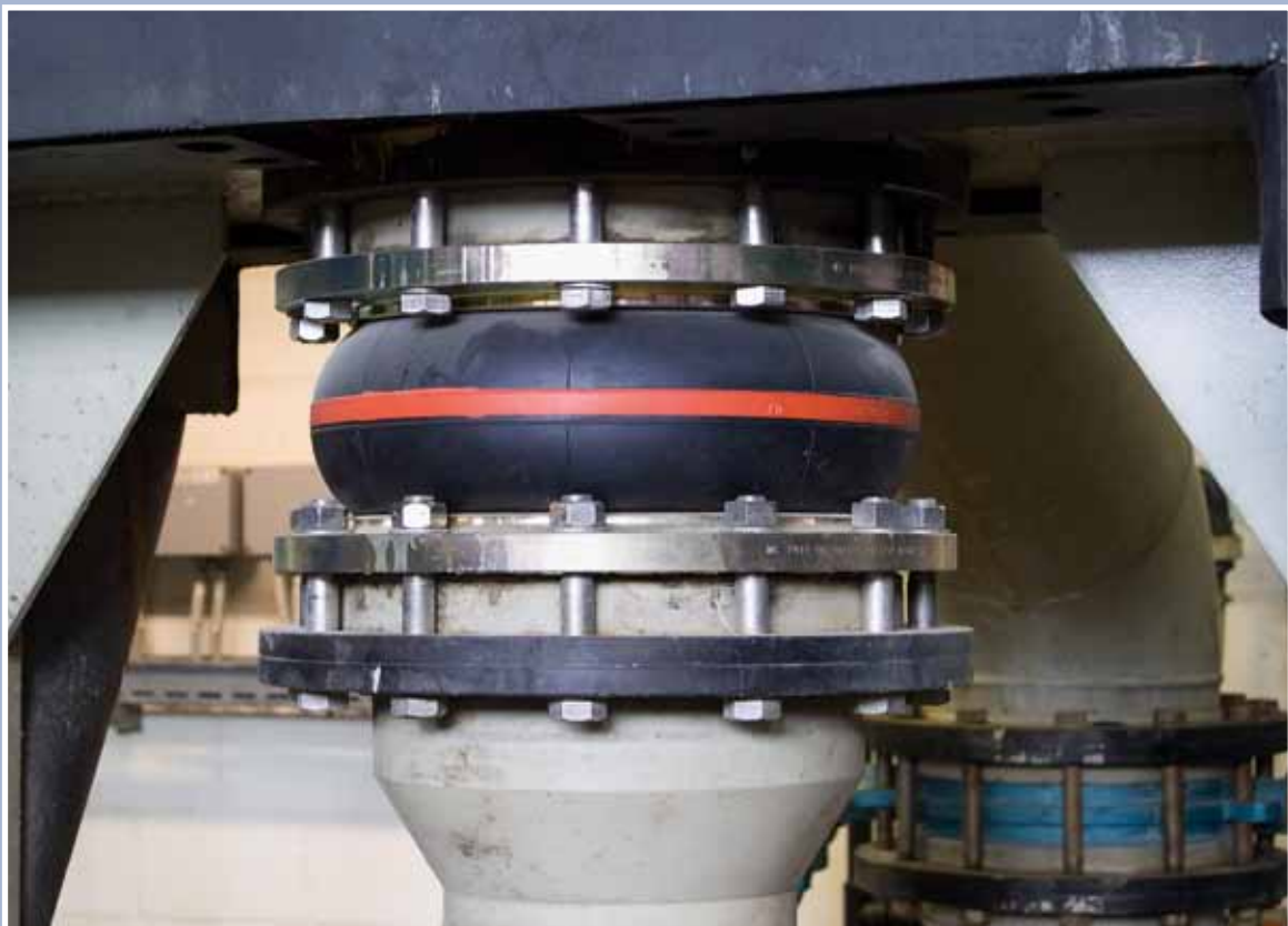
Universalkompensator Typ D110A in einer GFK-Leitung DN 250, 16 bar
