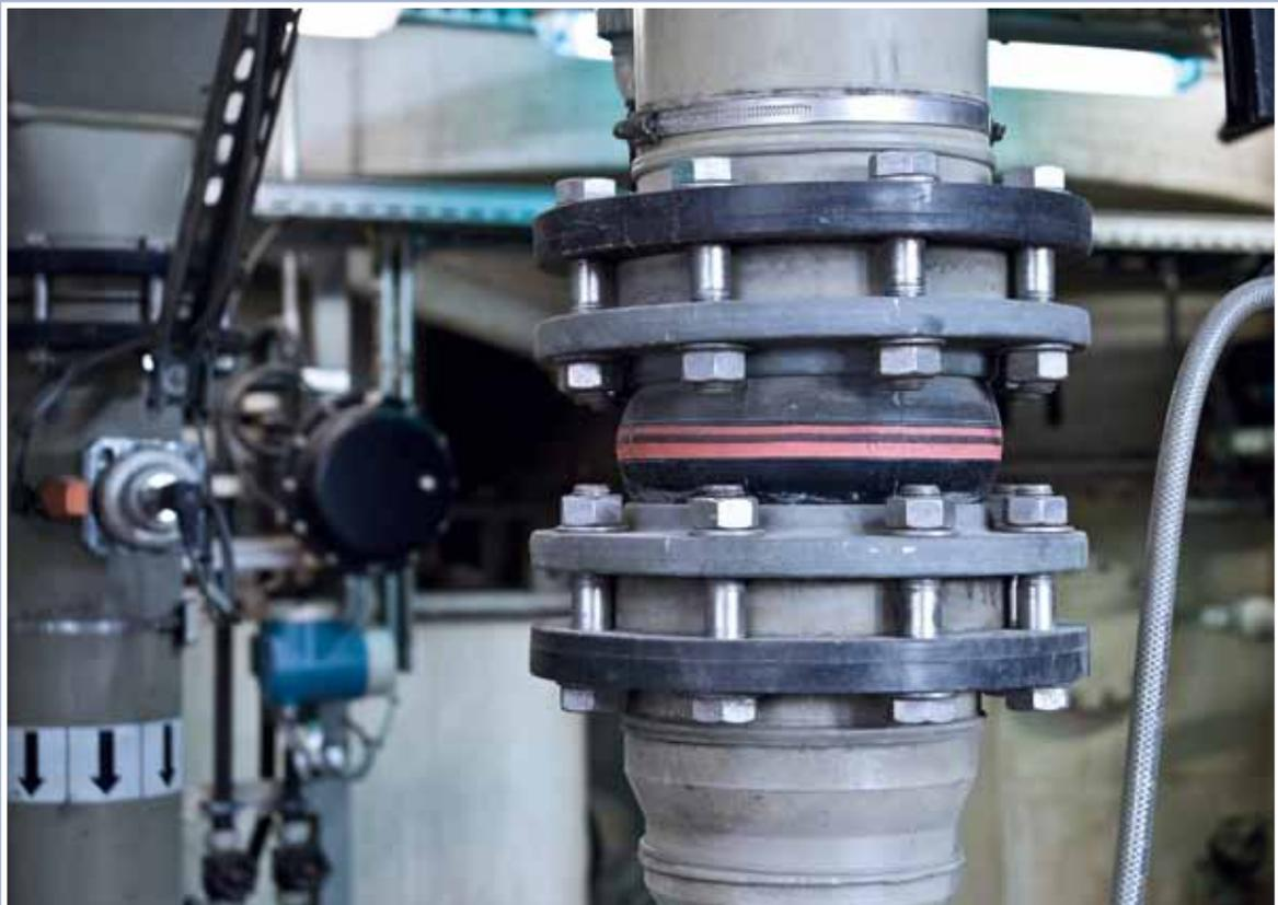
Universalkompensator Typ D110A
