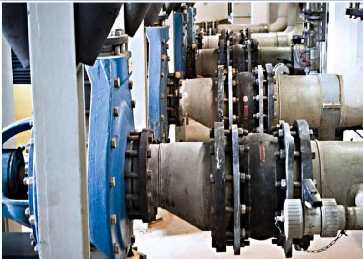
Universalkompensator Typ D110A
